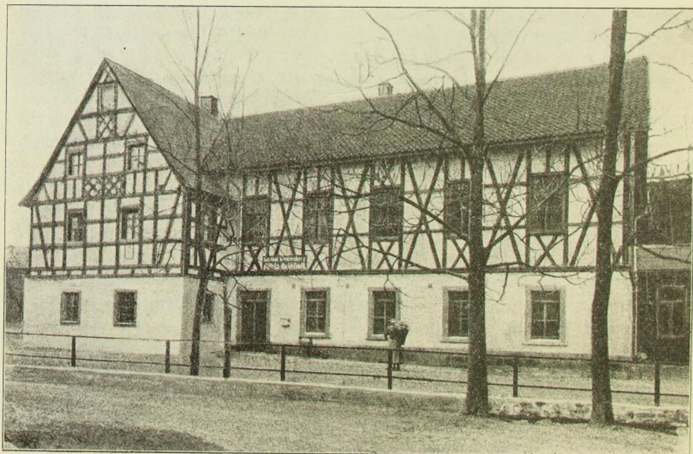
Abbildung 2. Neuer ungünstiger Anbau an die Längsseite neben dem schönen Giebel des Gasthofes Wiedersberg.
