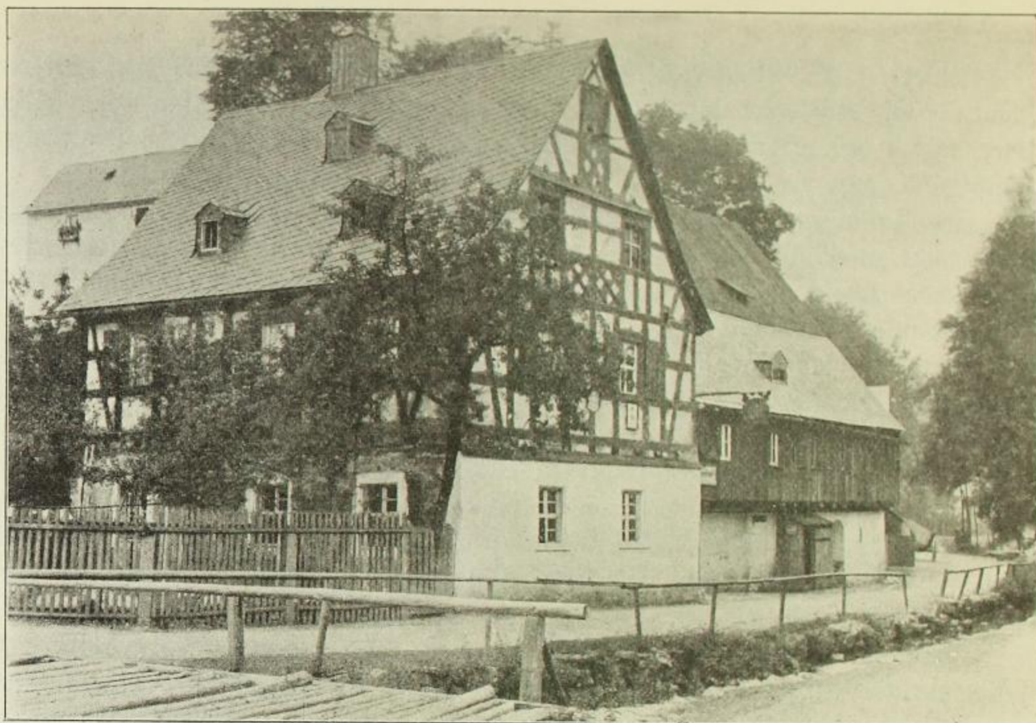
Abbildung 1. Alter Gasthof von Wiedersberg i. Vogtl., erbaut 1611. Vor dem Umbau fotogr. aufgenommen von Rich. Herold, Plauen. Preisgekrönte Photographie in der Zeitschrift: „Das Vogtland“.
