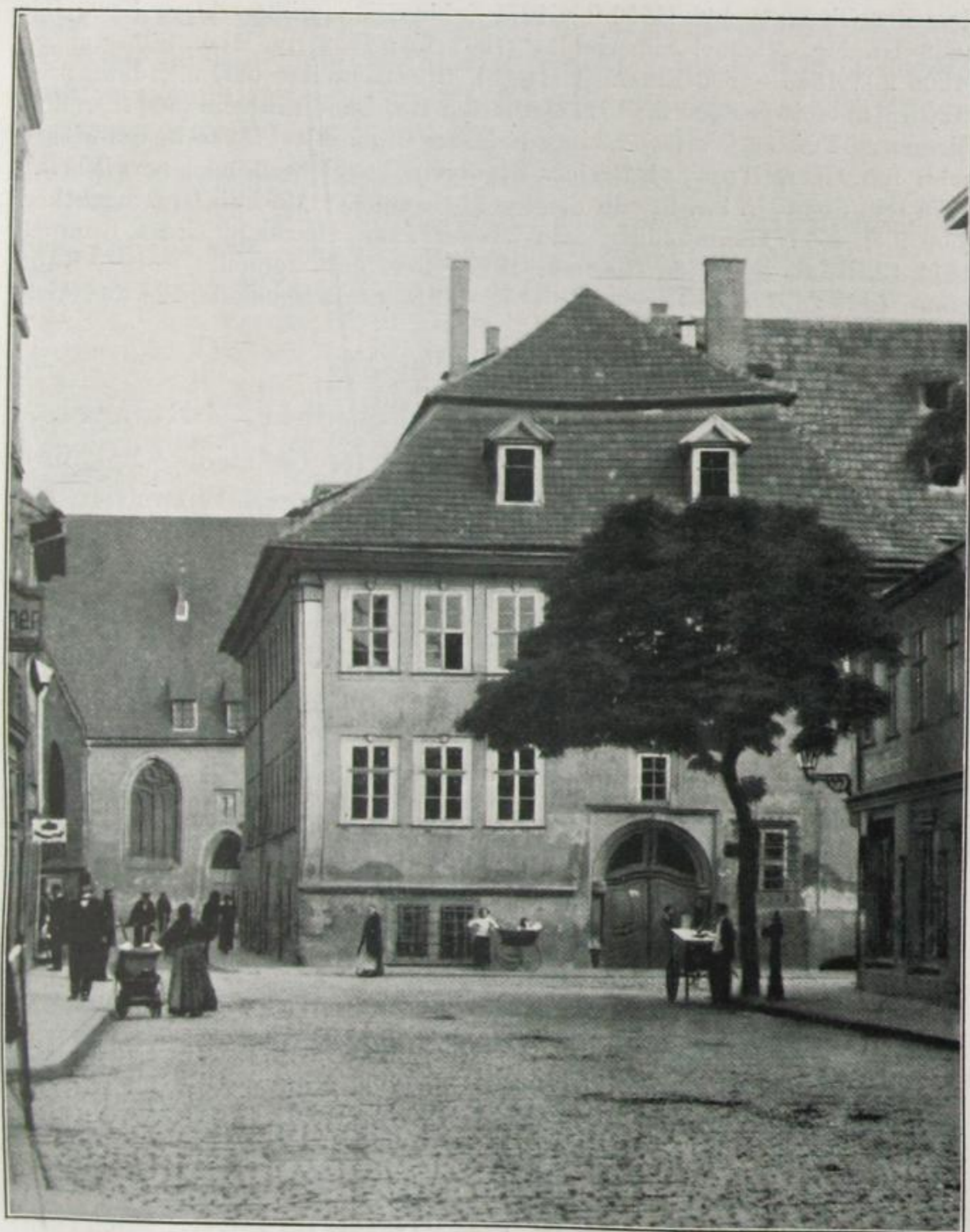
4. Blick vom Norden der Straße auf Nr. 14 (Einsiedel), [abgebrochen 1914] und auf die Michaeliskirche (gestaffelter Straßenabschluß).
