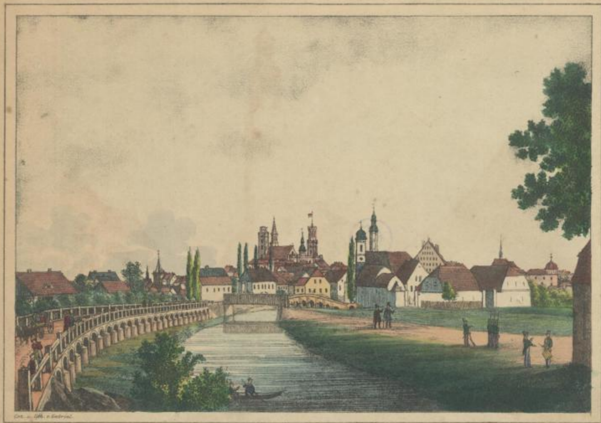
Ansicht von Bittau gegen Süden mit dem großen Viaduct auf der Straße nach Böhmen.
