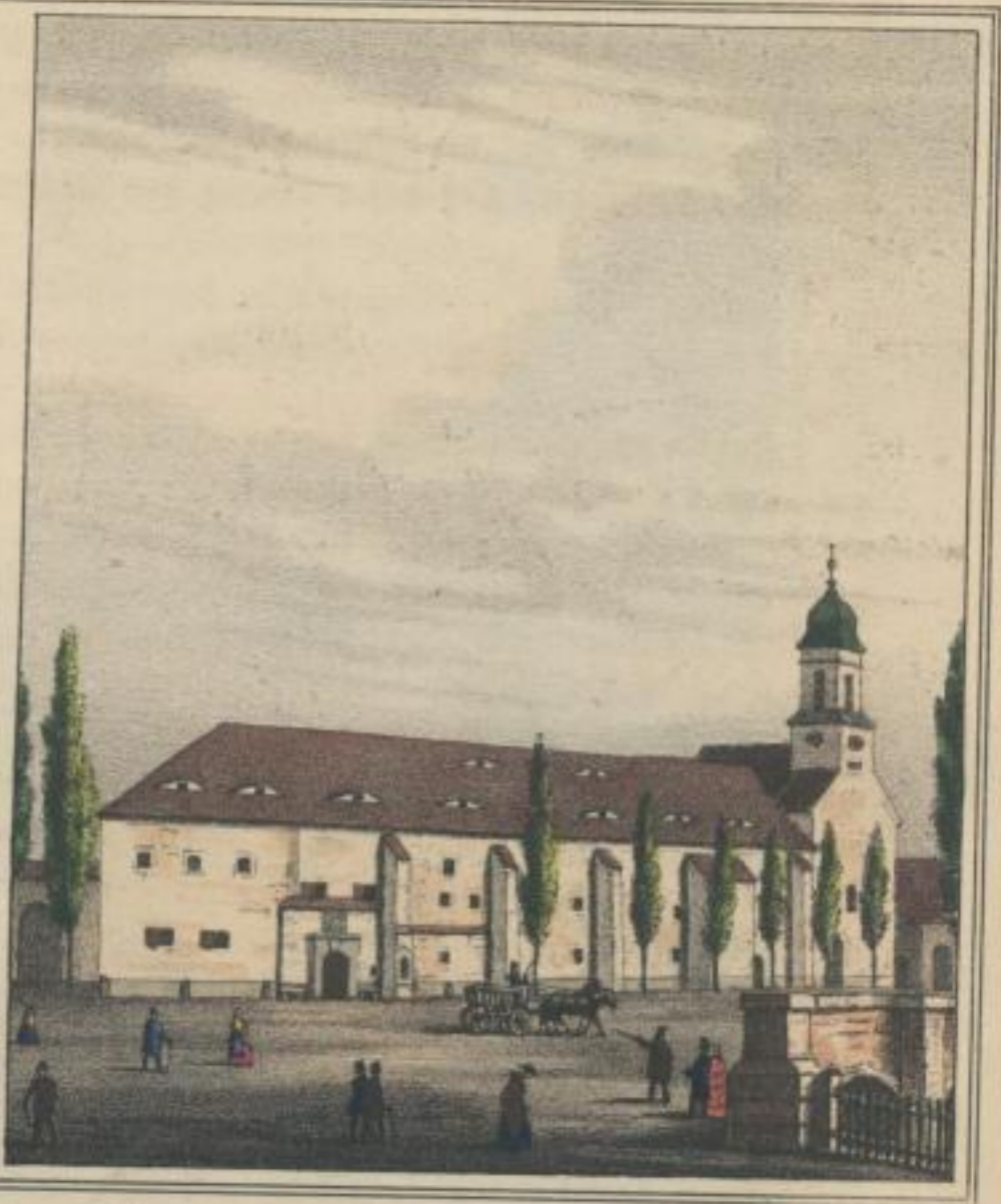
Das Hospital nebst Kirche in Bittau 1845.
