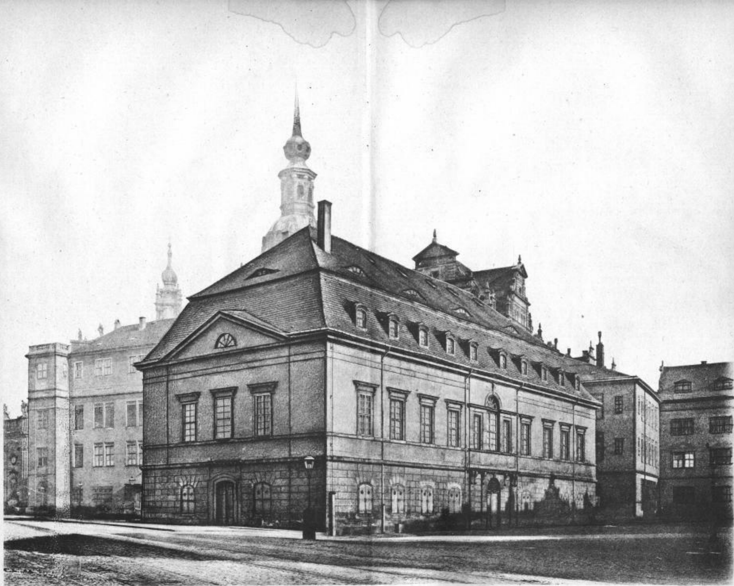
Das alte Archivgebäude vor seinem Abbruch.
