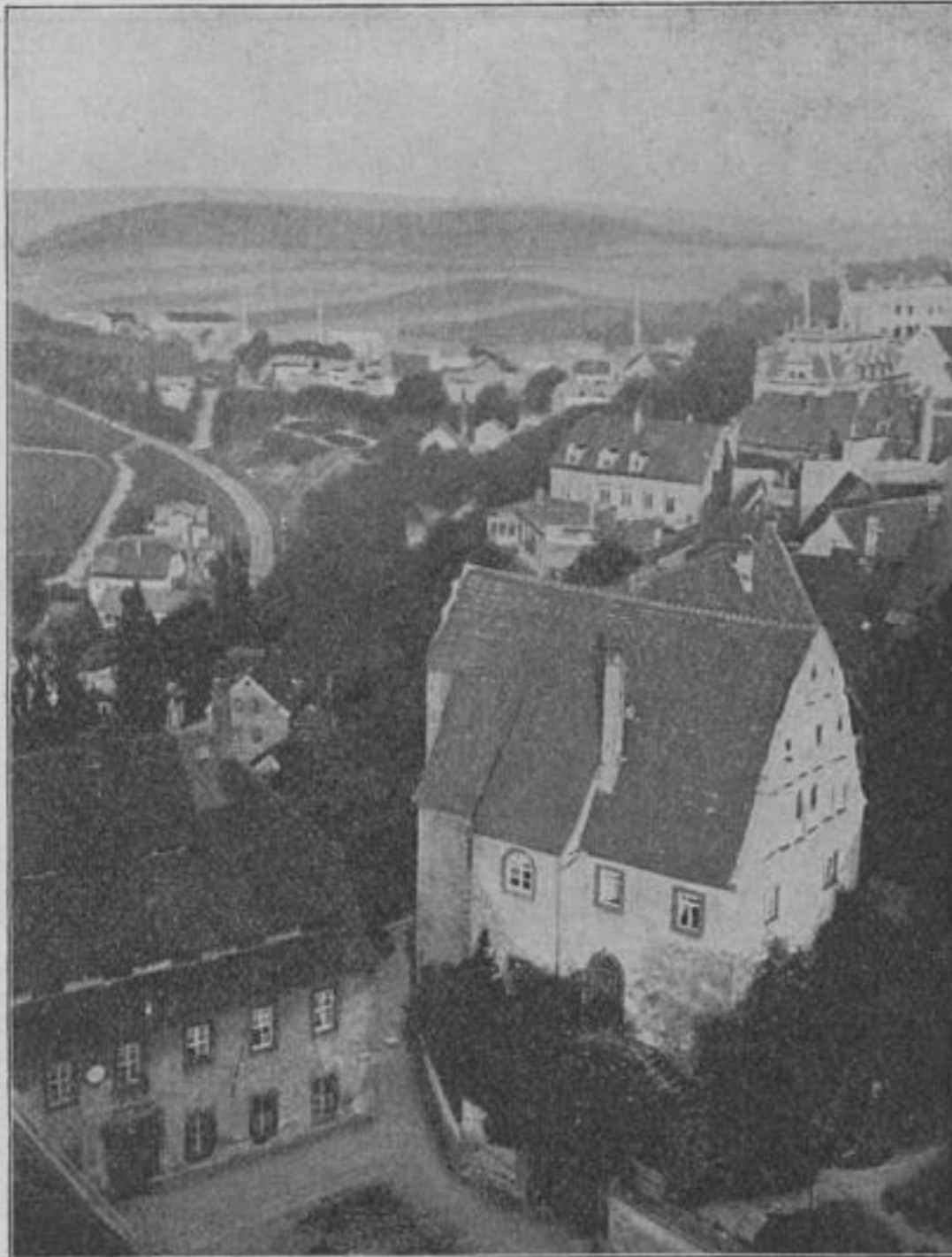
Superintendentur und alte Schule (Westseite).
