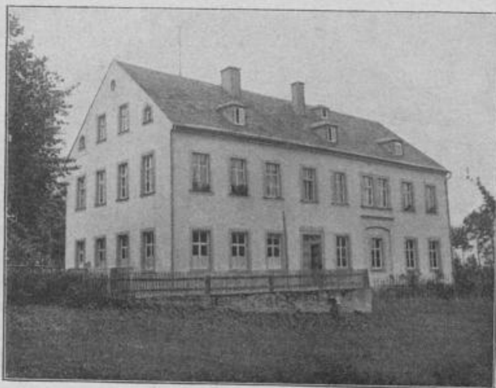
Schule zu Mitteldrebach, erweitert im Jahre 1893.
