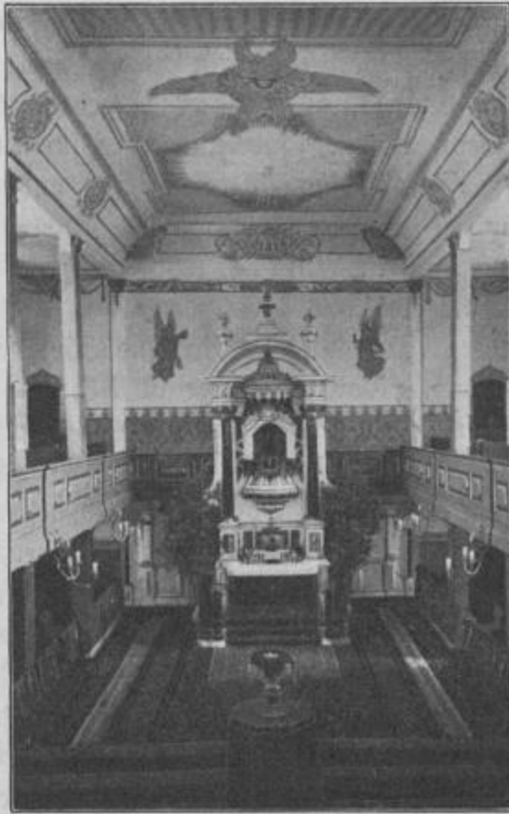
Inneres der Kirche zu Zöblitz nach der Renovation.
