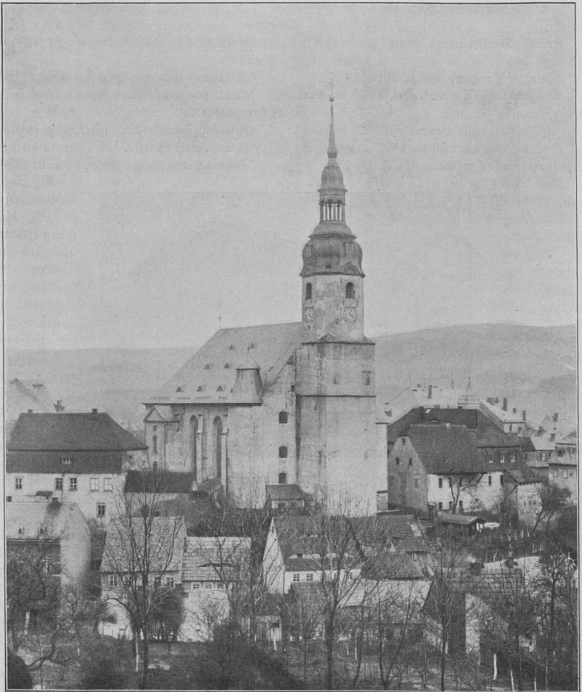
Stadtkirche in Zschopau 1899 (nach Aufnahme durch Photograph Zierold in Zschopau).
