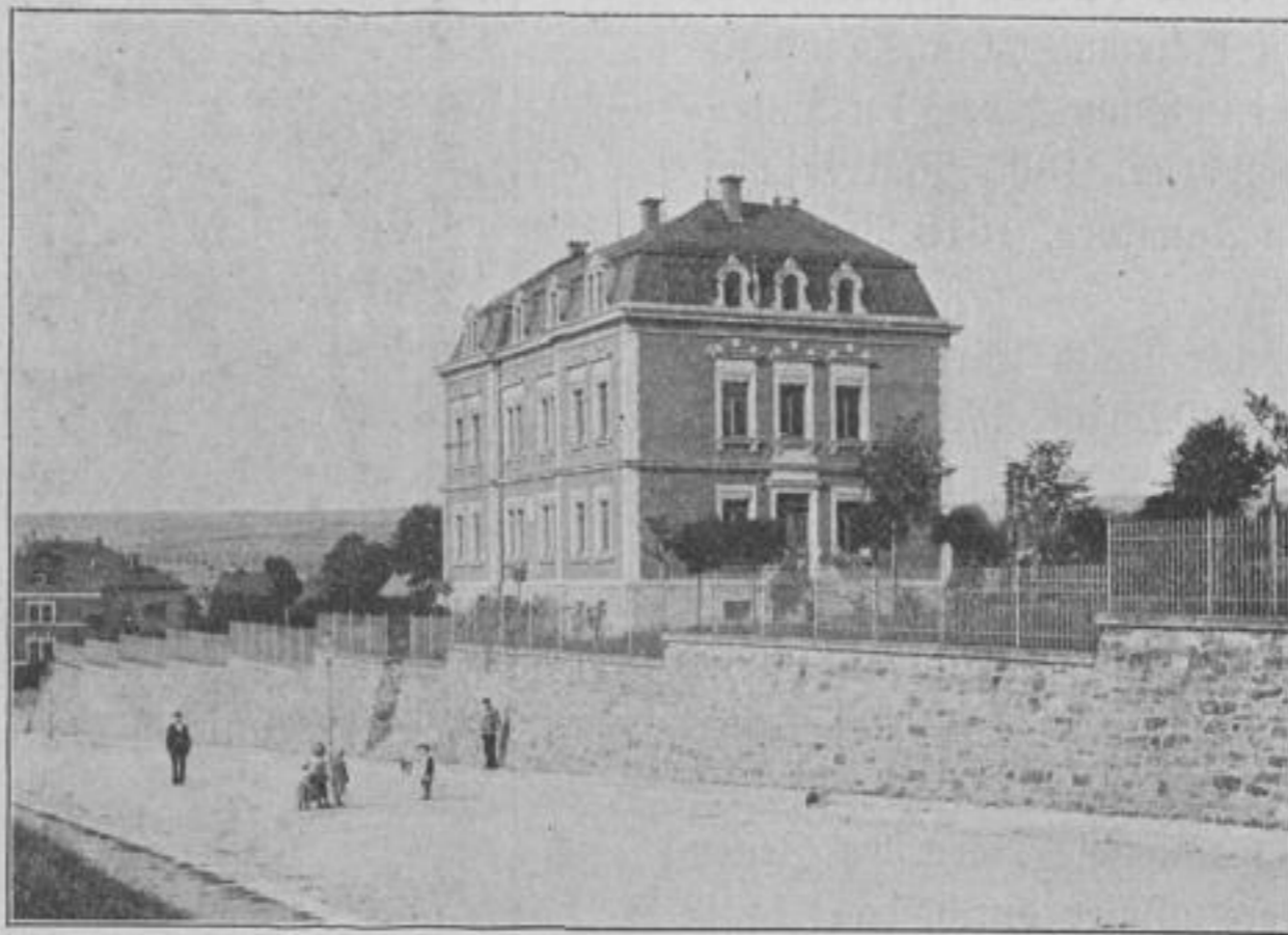
Stadtfrankenhaus in Zschopau.
