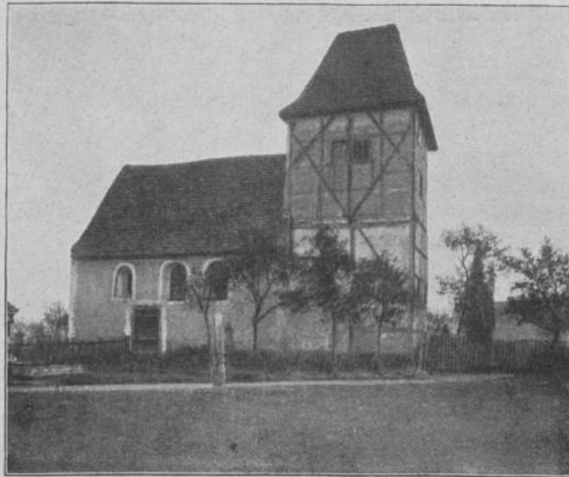
Alte Kirche zu Rohrbach, abgerissen Juni 1897.
