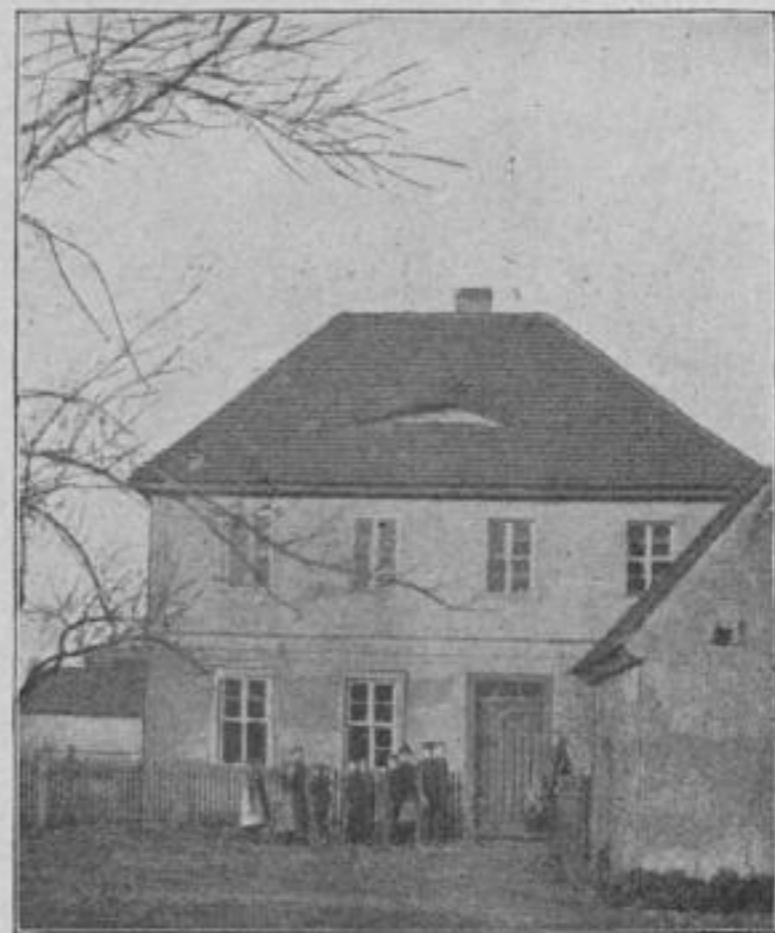
Schule zu Rohrbach.
