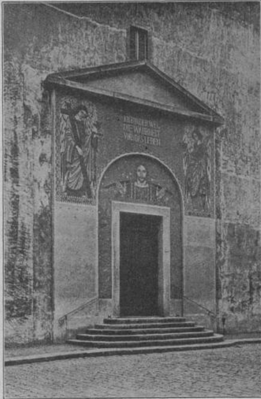
Portal der Hauptkirche zu Bischofswerda.
