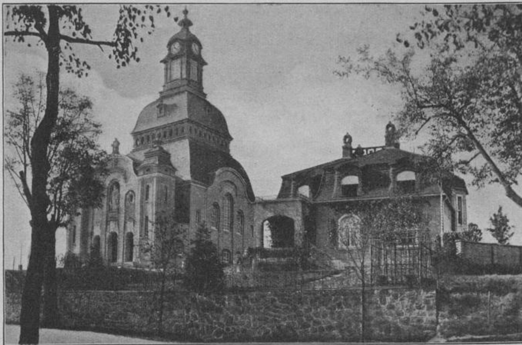
Kirche und Pfarrhaus zu Eisenberg-Moritzburg.
