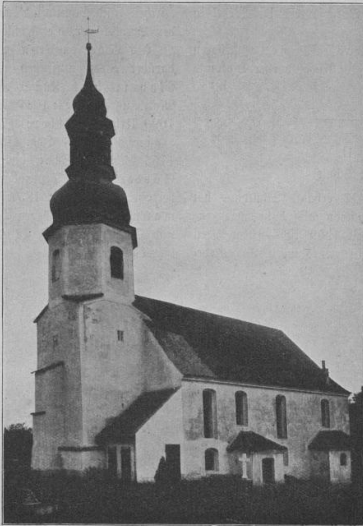
Kirche zu Goldbach vor der Erneuerung.
