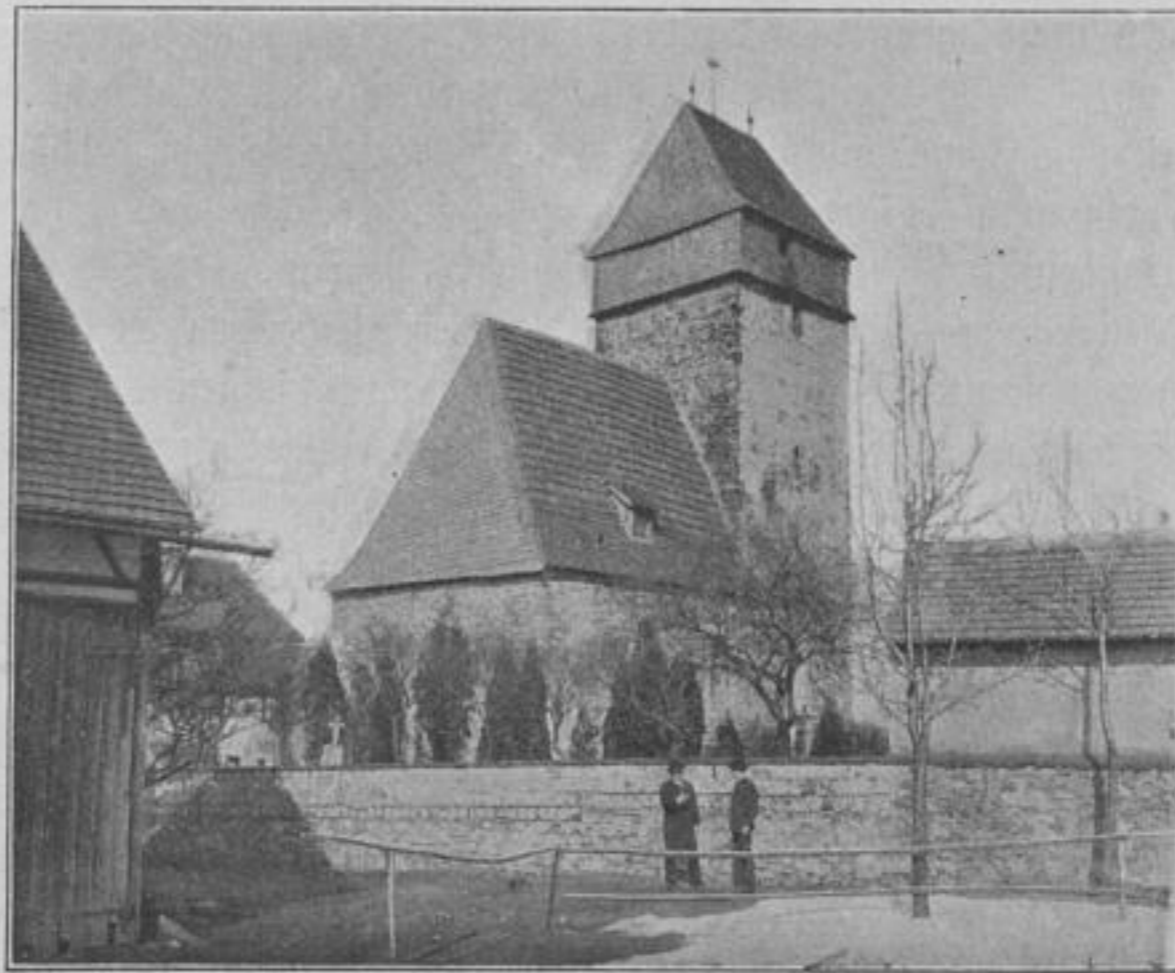
Kirche zu Rottmannsdorf vor der Erneuerung.
