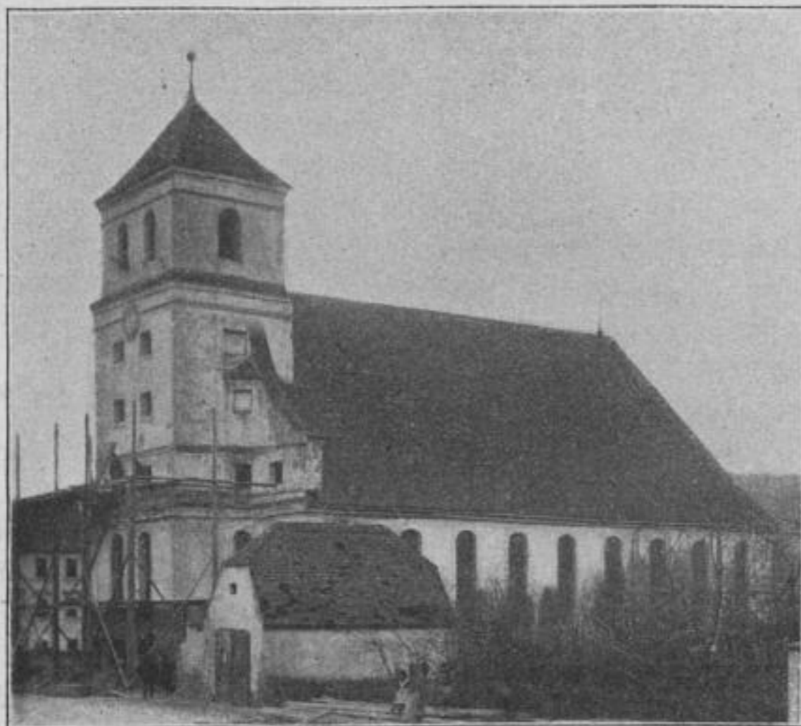
Kirche zu Postwitz am 5. April 1893, unmittelbar vor der Renovation mit Baugerüst.
