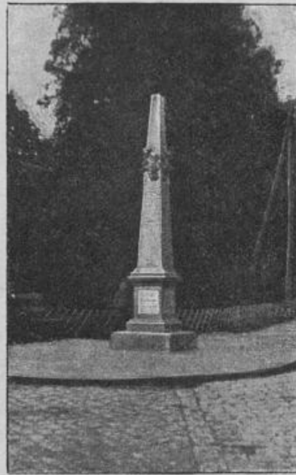
Die alte Postsäule in Pulsnitz.
