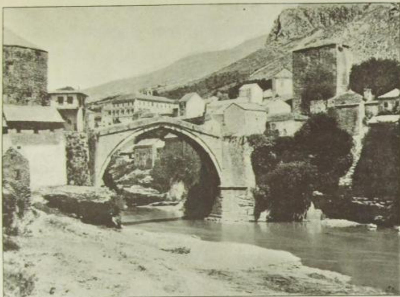
Die alte Brücke in Moslar (Herzegowina).
