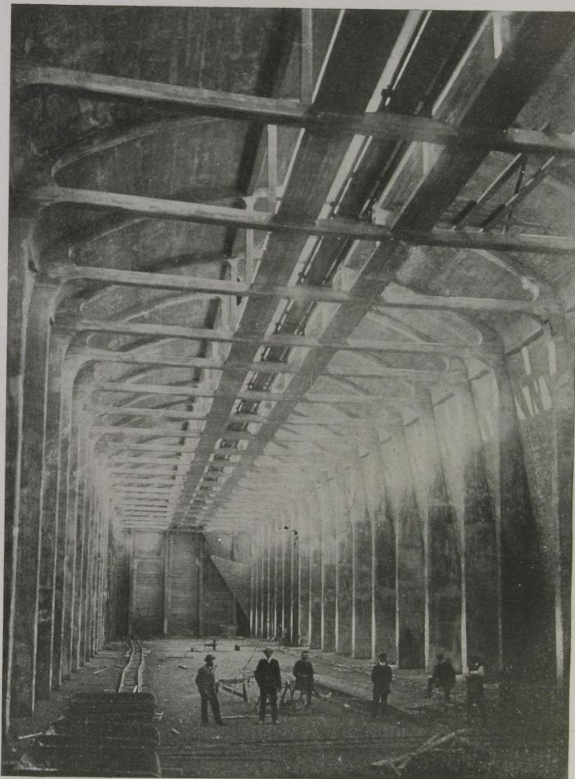
Rohschwetelsilo, Marseille (Wayss & Freitag) aus Linder „Ingenieurbauten“
