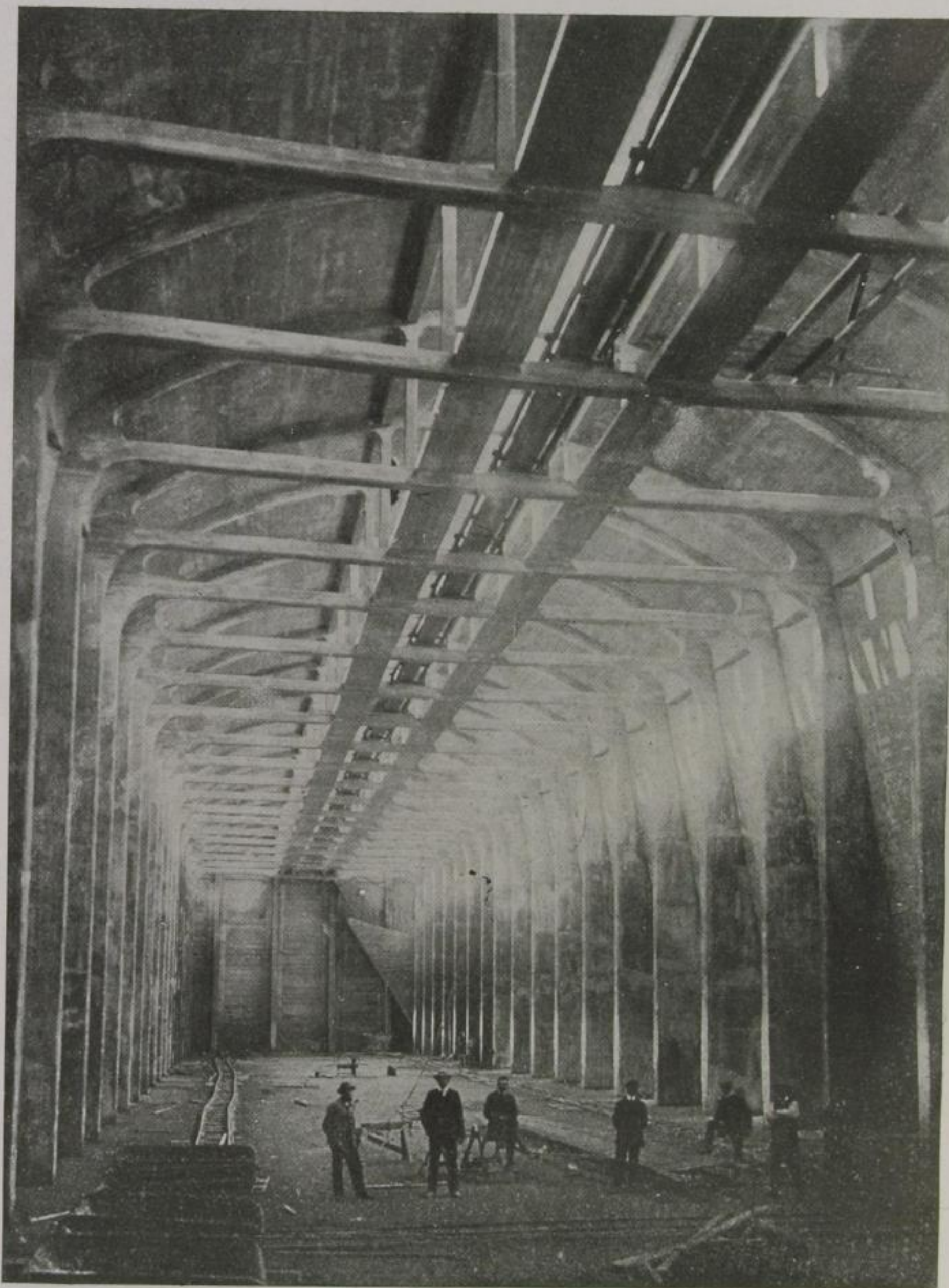
Rohschwetelsilo, Marseille (Wayss & Freitag) aus Linder „Ingenieurbauten“
