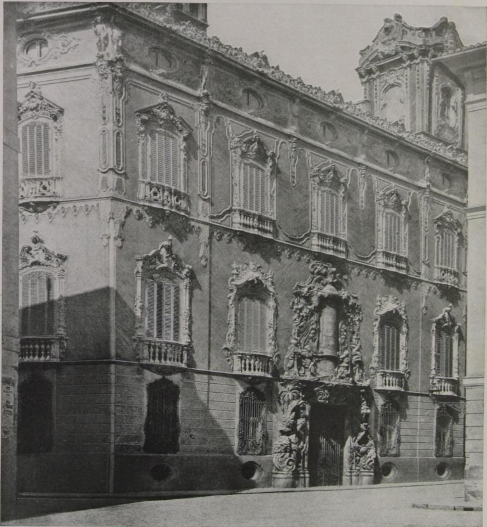
Haus des Marques de dos Aguas in Valencia
