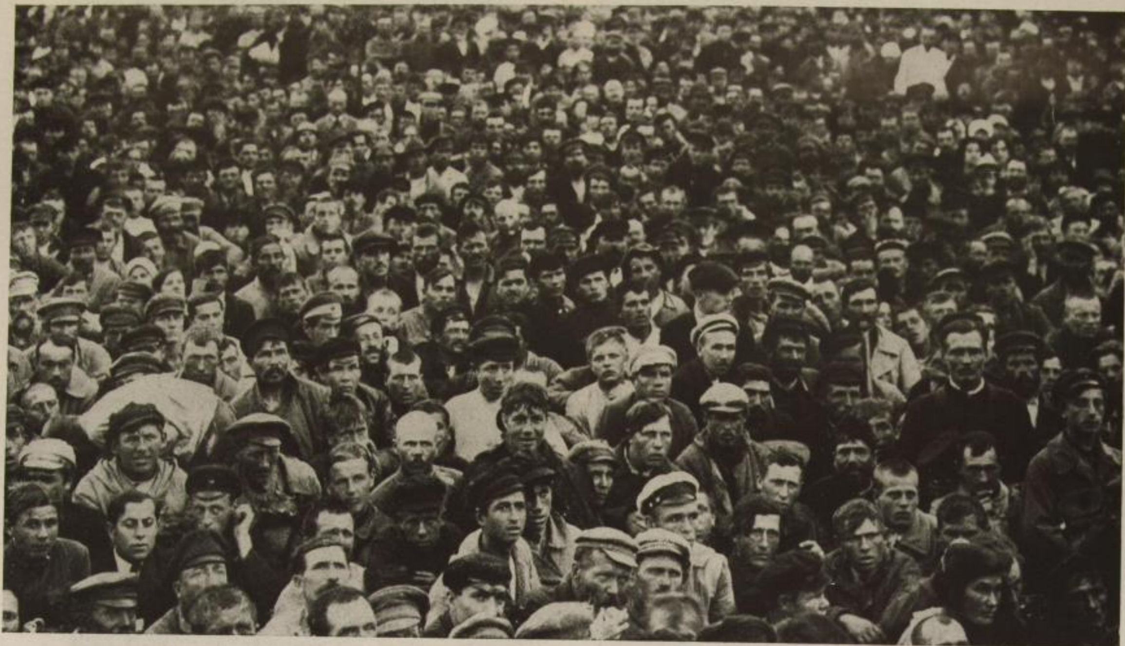
Der „Kollektive Mensch“. Konferenz der Bauarbeiter.
