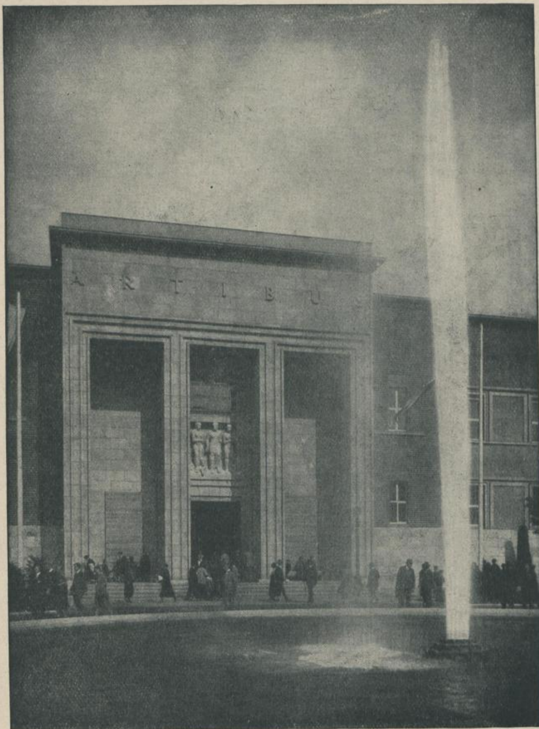
PORTAL DES KUNSTPALASTES IN DÜSSELDORF
