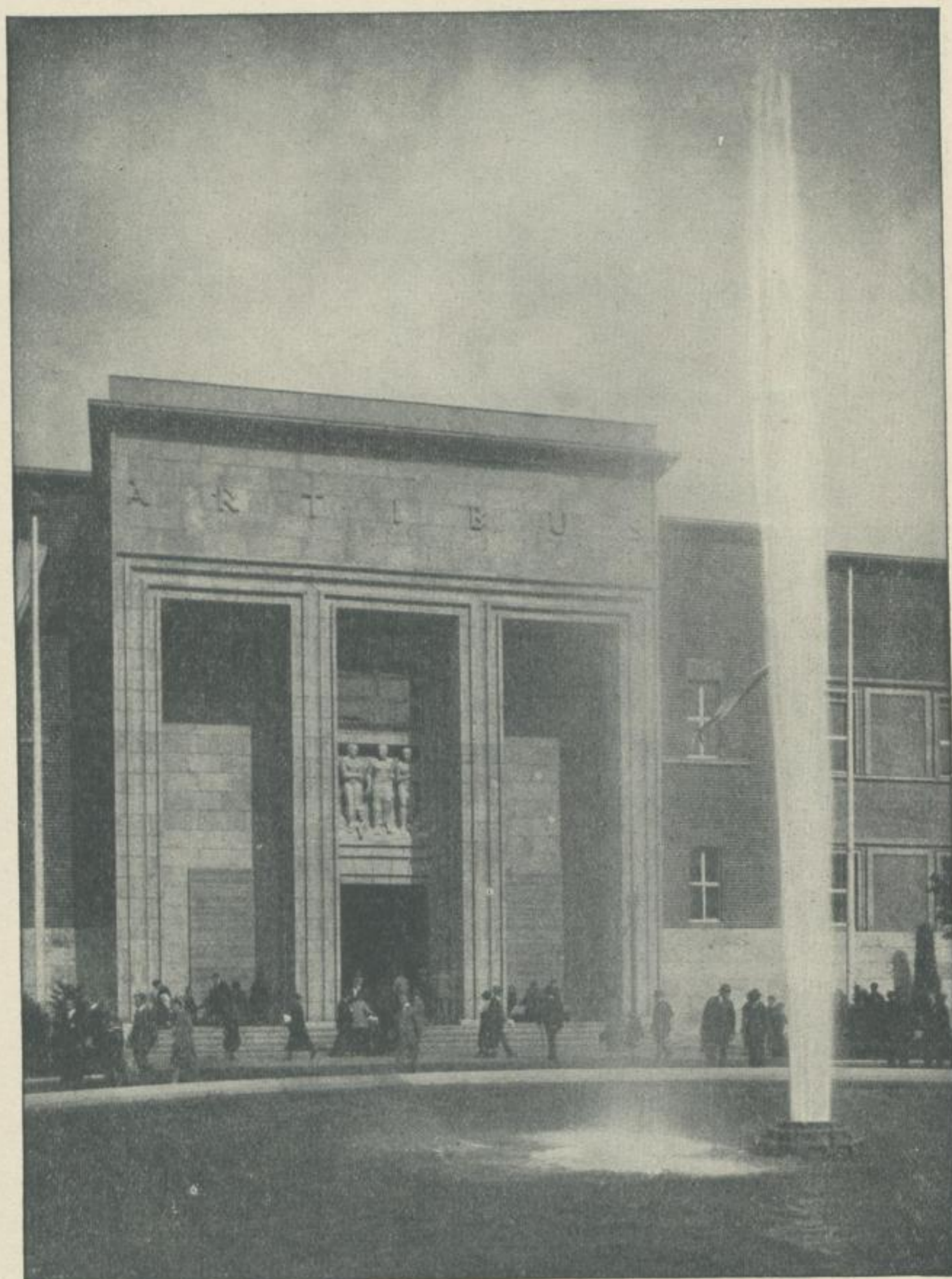
PORTAL DES KUNSTPALASTES IN DÜSSELDORF
