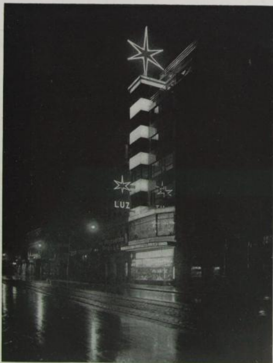
Das Luz-Haus (Architekt Richard Döcker)
