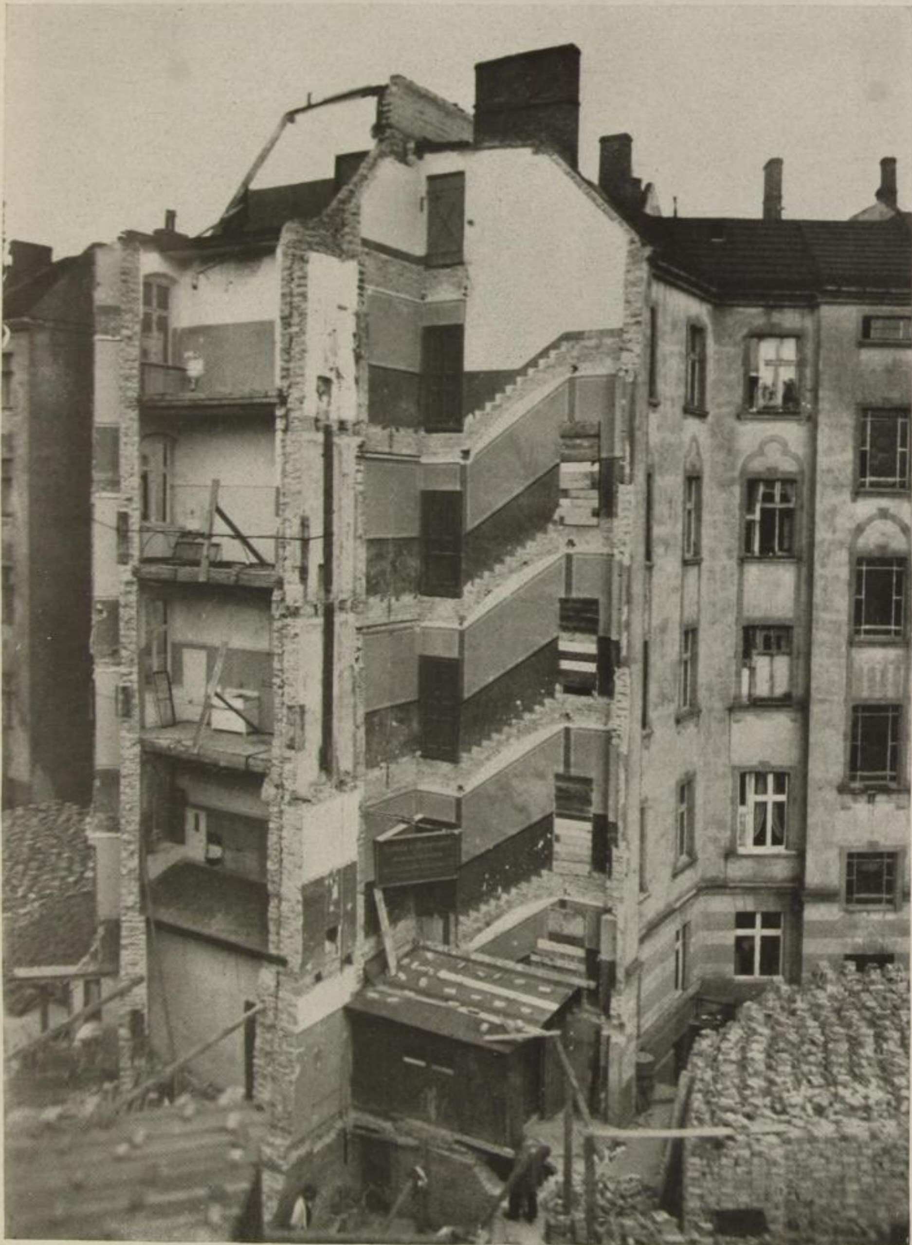
Ein Haus wird abgerissen
