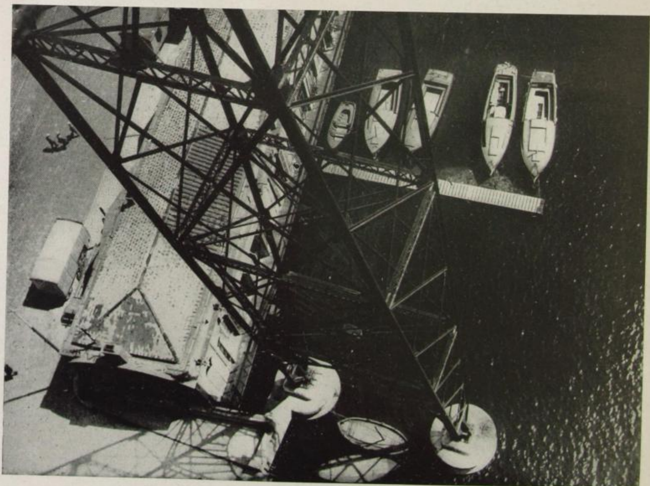
Blick vom Kran
