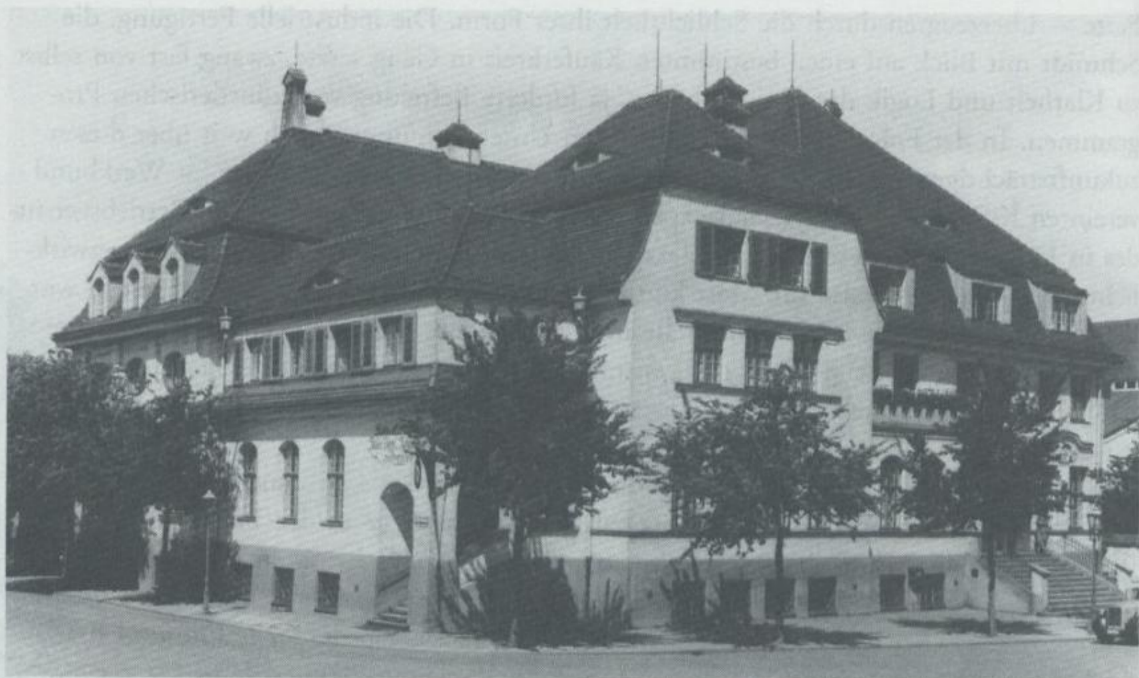
Schlachthof Dresden, 1906–1910 von Hans Erlwein erbaut, Verwaltungsgebäude
