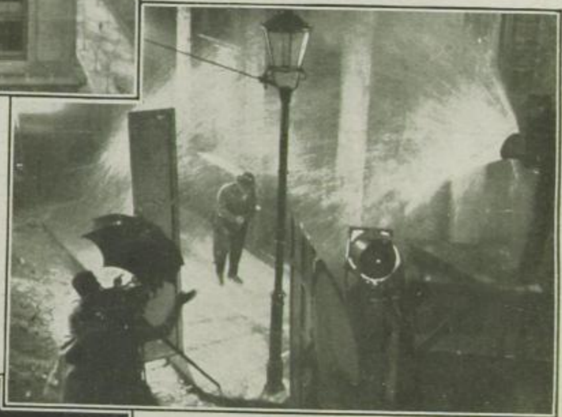
Der Platzregen im Glashaus
