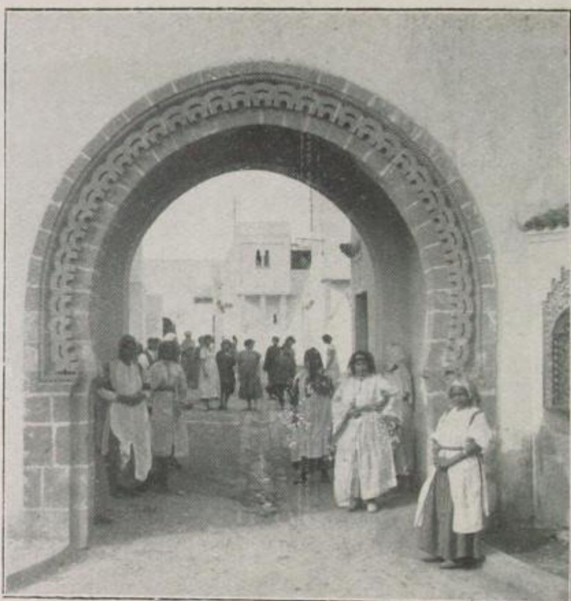
Inmitten der schmucken Straße eine Rinne für das Abwasser. Keine Kanalisation aber elektrisches Licht
