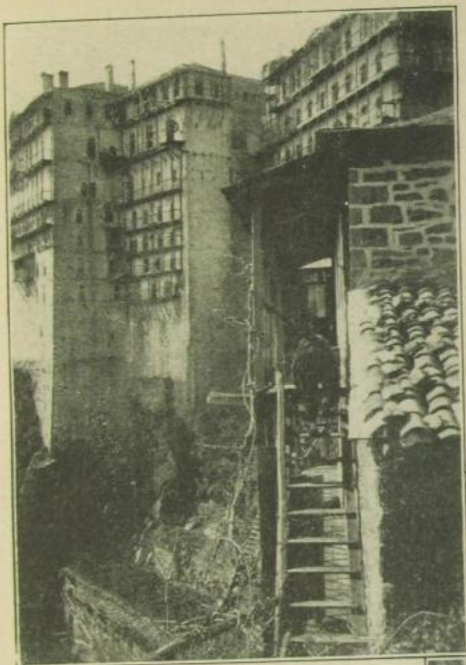
Wie ein Schwalbennest ist das Kloster an den Berg gebaut
