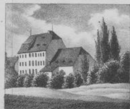
Die Grossmann'sche Fabrik.
