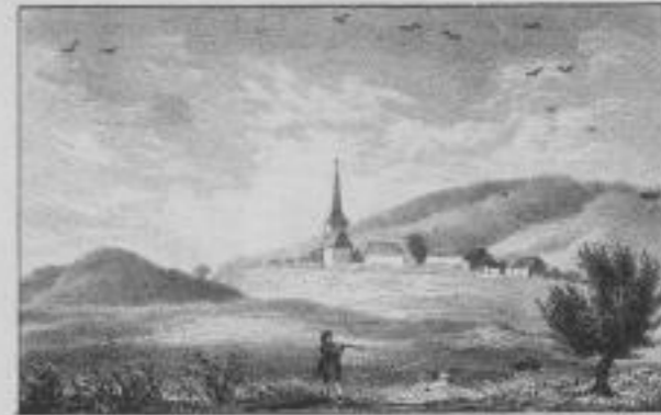
Nordwestliche Ansicht v. Langenberg.
