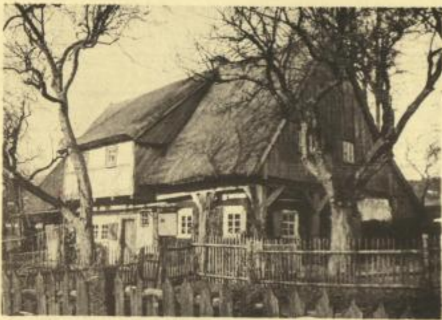
Wohnhaus in Langburkersdorf (Ober-Lausitz)
