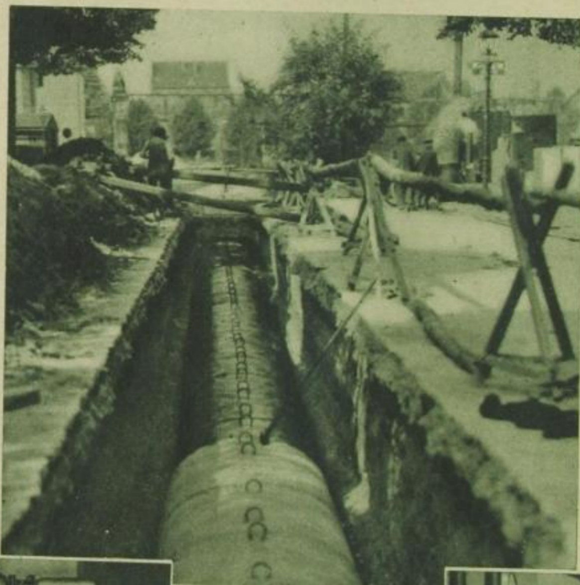
Oben: Mit Isolierschichten abgedeckter Heizkanal
