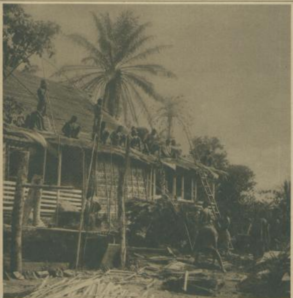
in Lambarene (Kongogebiet) wird mit Blätterziegeln neu gedeckt
