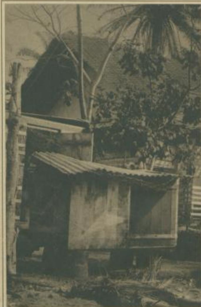
Das Dach des alten Doktorhauses
