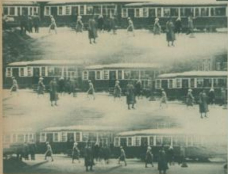
Morgendliches Hasten zur Arbeitsstätte
