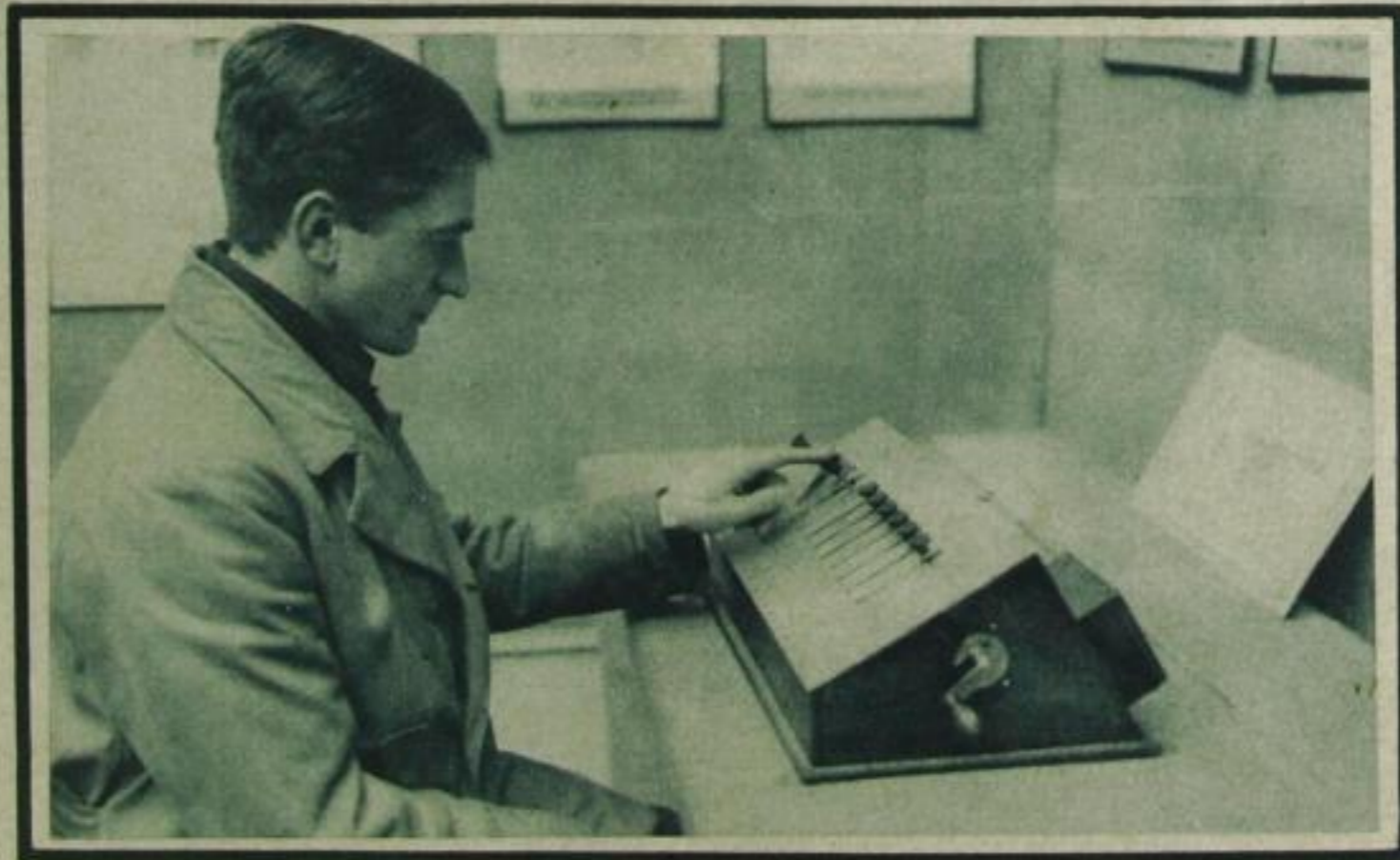
Langweilprüfer für mechanische Arbeit. Die Versuchsperson soll mechanisch hintereinander die einzelnen Knöpfe des Apparates niederdrücken, und nachdem die Reihe der 10 Knöpfe erledigt ist, die rechts am Apparat befindliche Kurbel einmal herumdrehen, wodurch die Knöpfe wieder in ihre ursprüngliche Lage zurückkehren. Die Gesamtzahl der Leistung wird durch Zählwerk vermerkt. Mogeln am Apparat ist unmöglich, da die einzelnen Druckknöpfe und der Handgriff zwangsläufig miteinander verbunden sind
