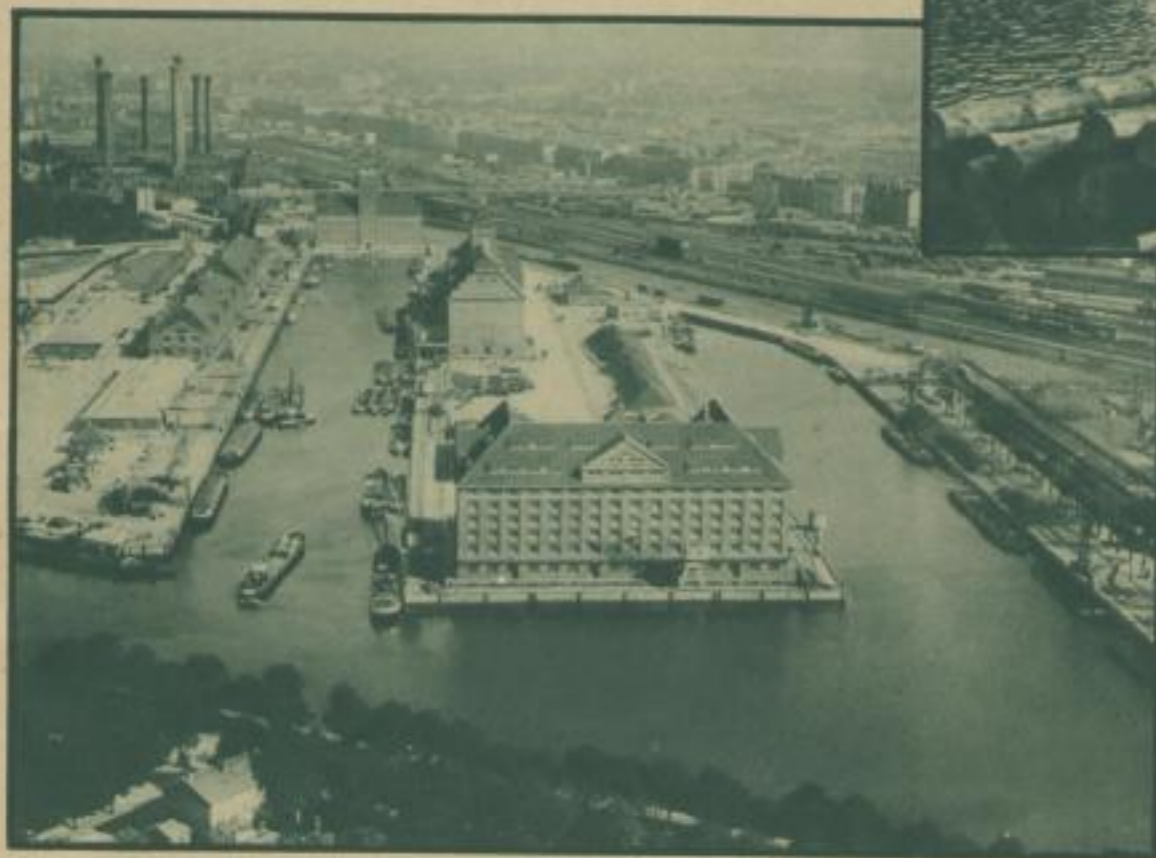
Luftaufnahme vom Berliner Westhafen: Große moderne Speicher und Getreidesilos für den Warenaustausch mit dem Norden und Westen. Im Hintergrund die Anschlußgleise für den Bahnumschlag, die Ringbahn und das Häusermeer der Stadt
