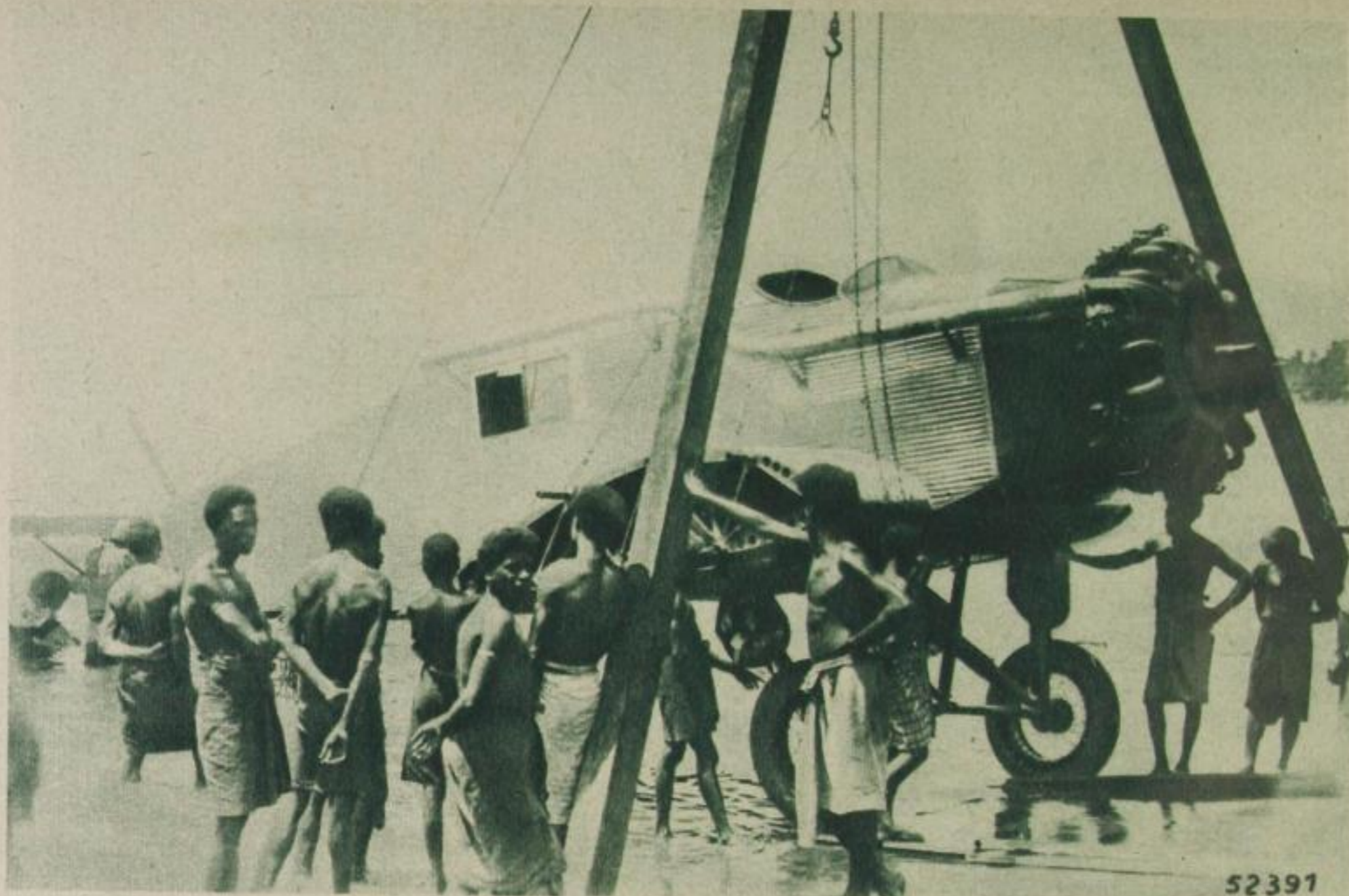
Von Australiens Goldfeldern zur Küste. Junkers-W 34 (Bremen-Typ) im australischen Dienst bei Lae. Auswechseln der Schwimmer gegen Fahrgestell. Die Tragflächen zur Sicherheitskontrolle abmontiert
