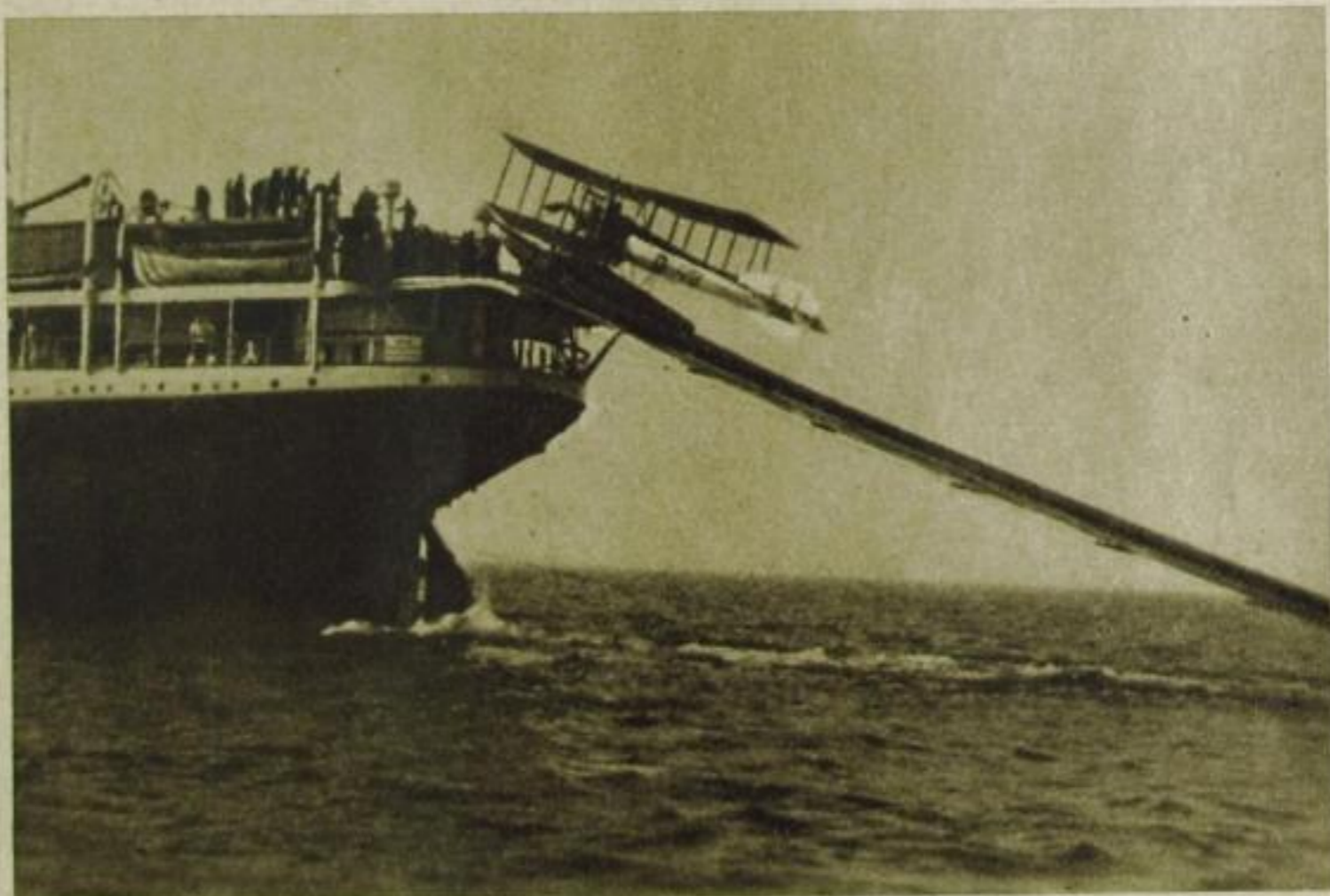
Stausegel-Anlage an Bord der „Lützow“: Eine 30 m lange Staubahn am Heck des Dampfers bietet selbst im Seegang Landungsgelegenheit für das ankommende Katapult-Flugzeug
