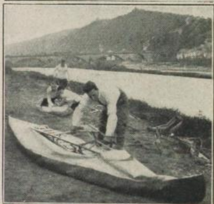
Das Klepperboot zusammengelegt auf Fahrgestell und das Aufbauen zur Wanderfahrt
