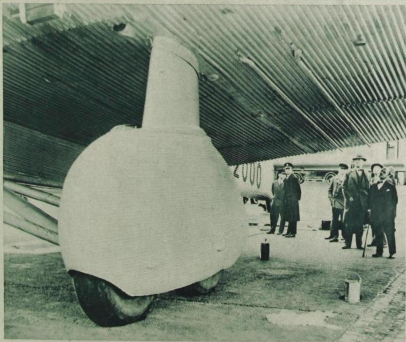
Die Maschine ruht auf einem Fahrgestell mit 4 Rädern von 1,50 m Durchmesser, je 2 unter einer Radverkleidung. Jedes Rad ist mit Luftdruckbremse versehen
