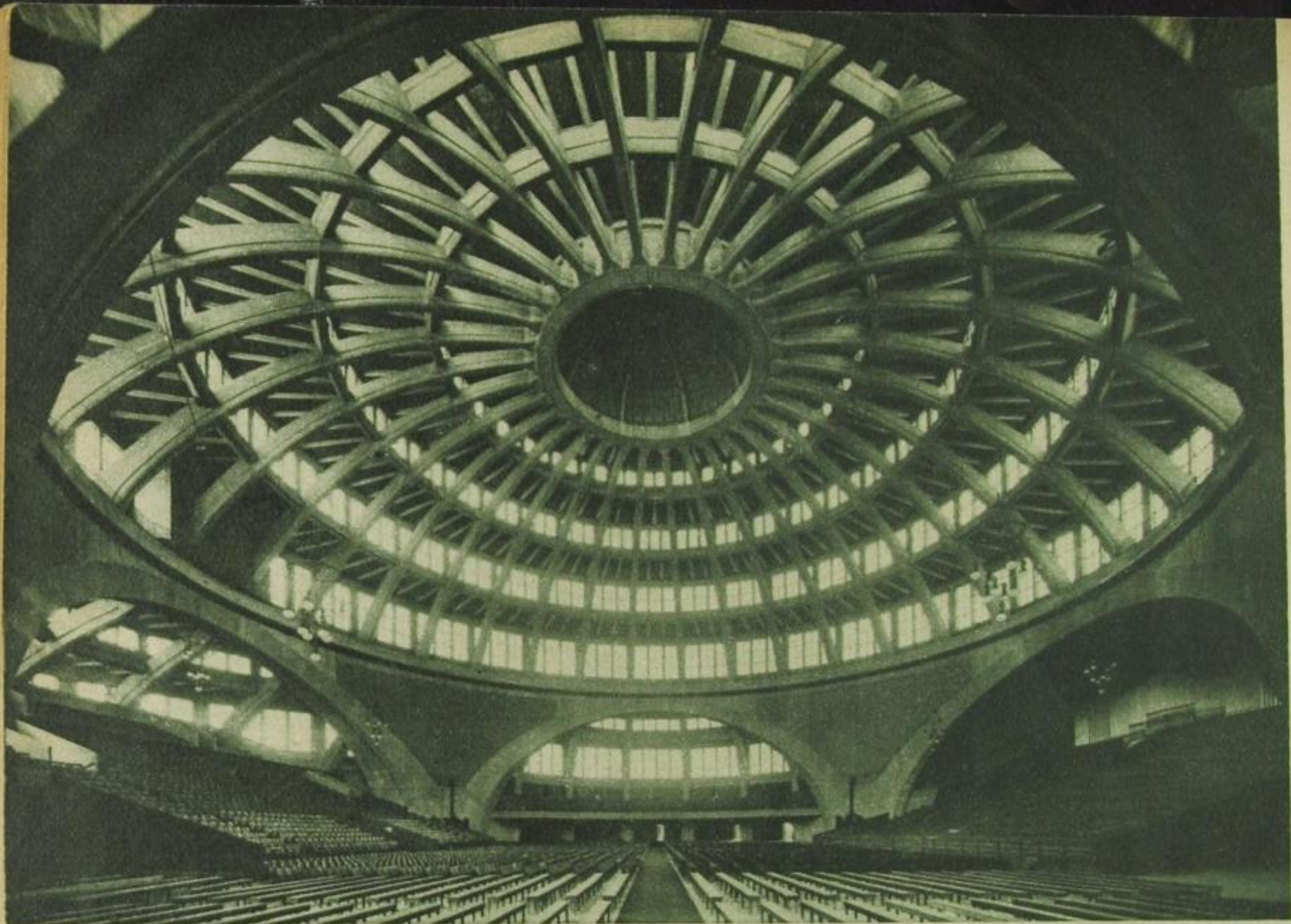
Der gigantischste Kuppelbau der Welt: Inneres der Breslauer Jahrhunderthalle, eine Eisenbetonwölbung von 66 m freier Spannweite, trotz des schweren Materials von leichtester Beswingtheit (Klettephoto) Architekt: Stadtbaurat Max Berg
