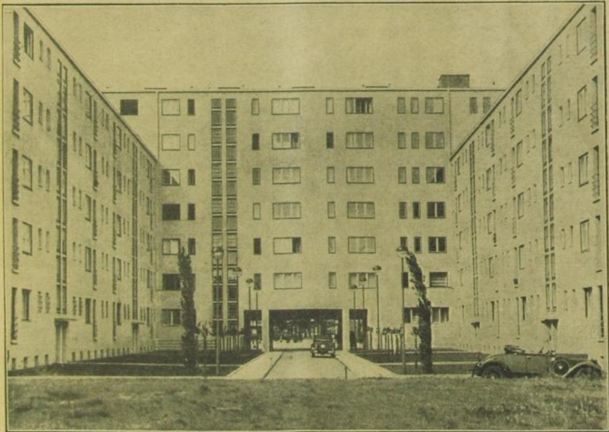
Der hufeisenförmige Innenhof des Junggesellenhotels
