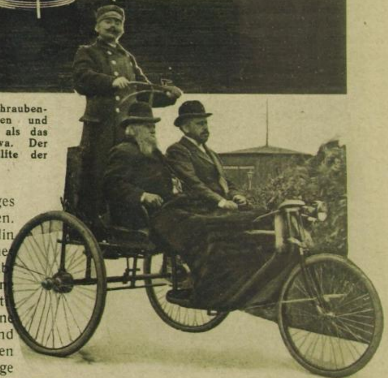
Der Tretmotorwagen, auch eine Schöpfung des vielseitigen Erfinders. In 2 Stunden fuhr dieser Wagen mit 3 Personen die Strecke Schöneberg—Potsdam.
