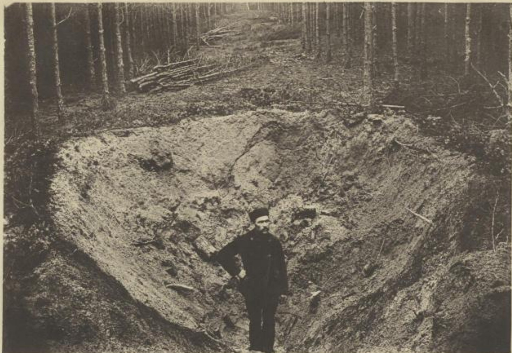
Trichter in Erde, gesprengt durch eine 21-cm-Granate mit 14-Kg. Schiesswolle geladen. Walsrode December 1887.
