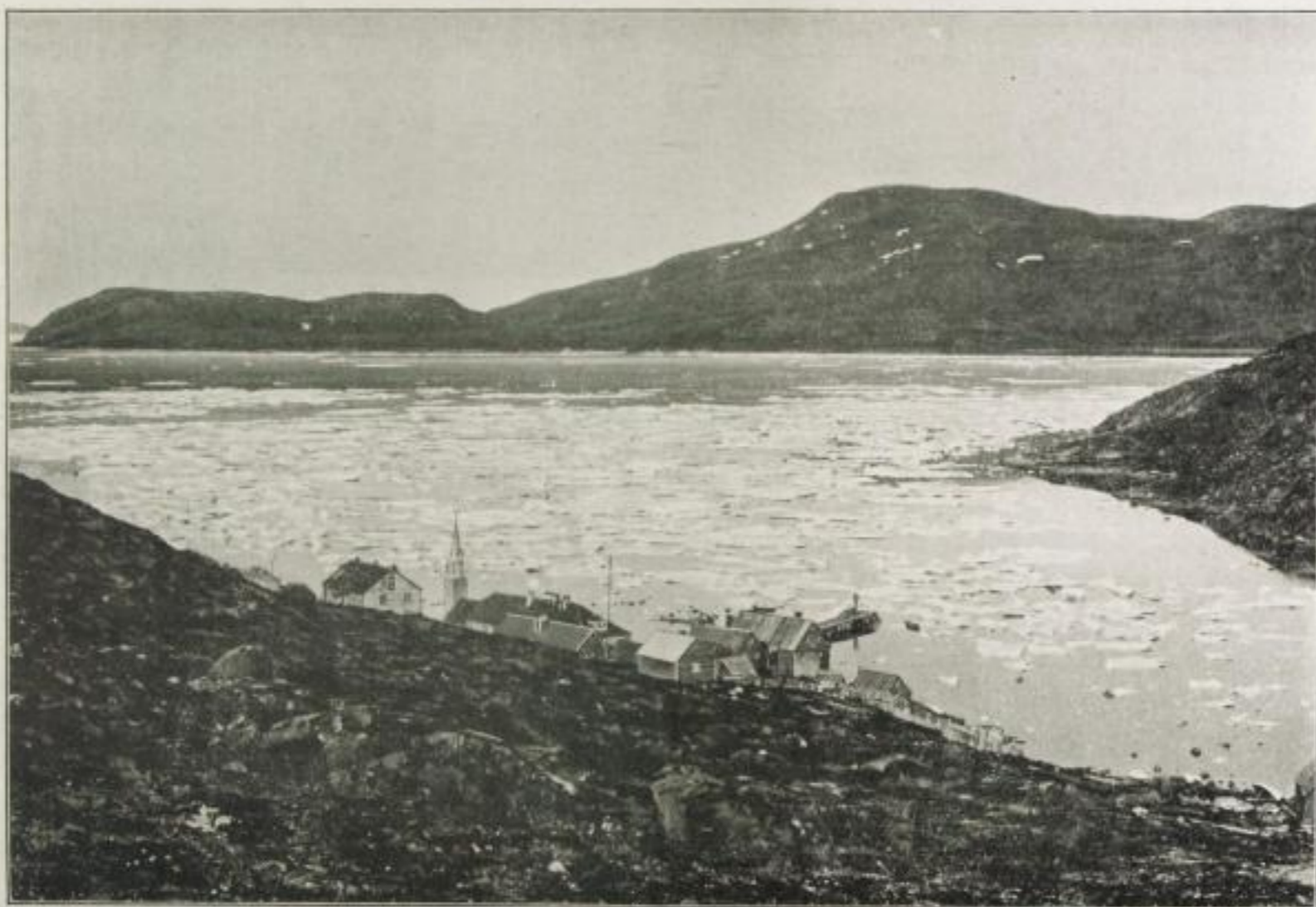
Bucht von Okak mit der Station, rechts das Hospital.
