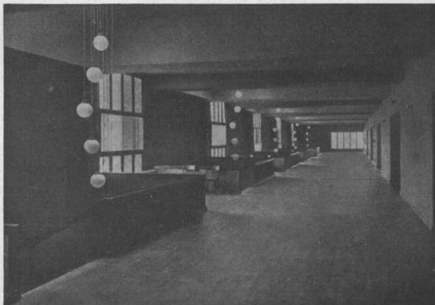
Ein Wandelgang in der Stadthalle Magdeburg. In den Wandelgängen um den Versammlungssaal wird dieses Mal die Ausstellung aufgebaut. (VI 1/555)
