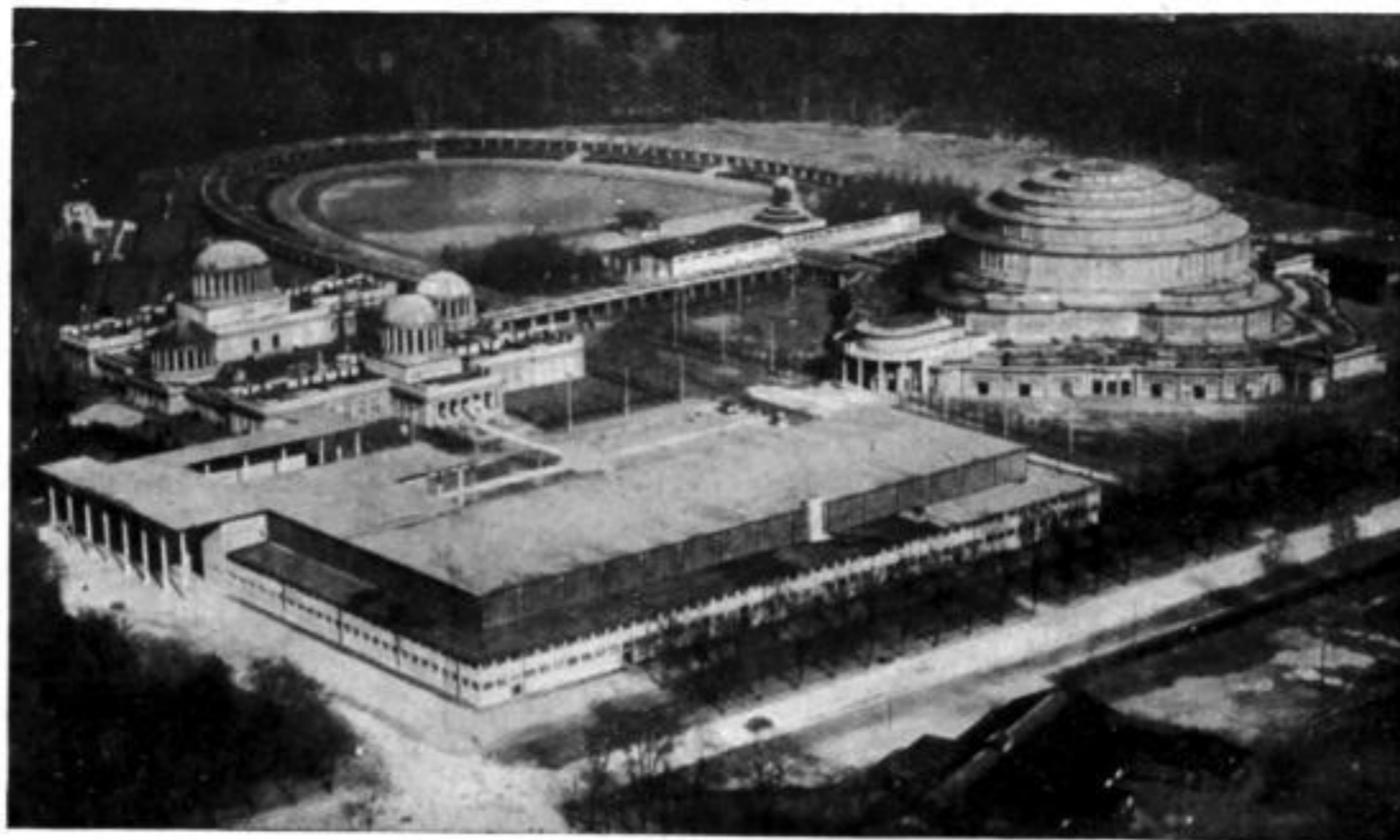
Die Jahrhunderthalle in Breslau, der Ort der Tagung des Zentralverbandes
