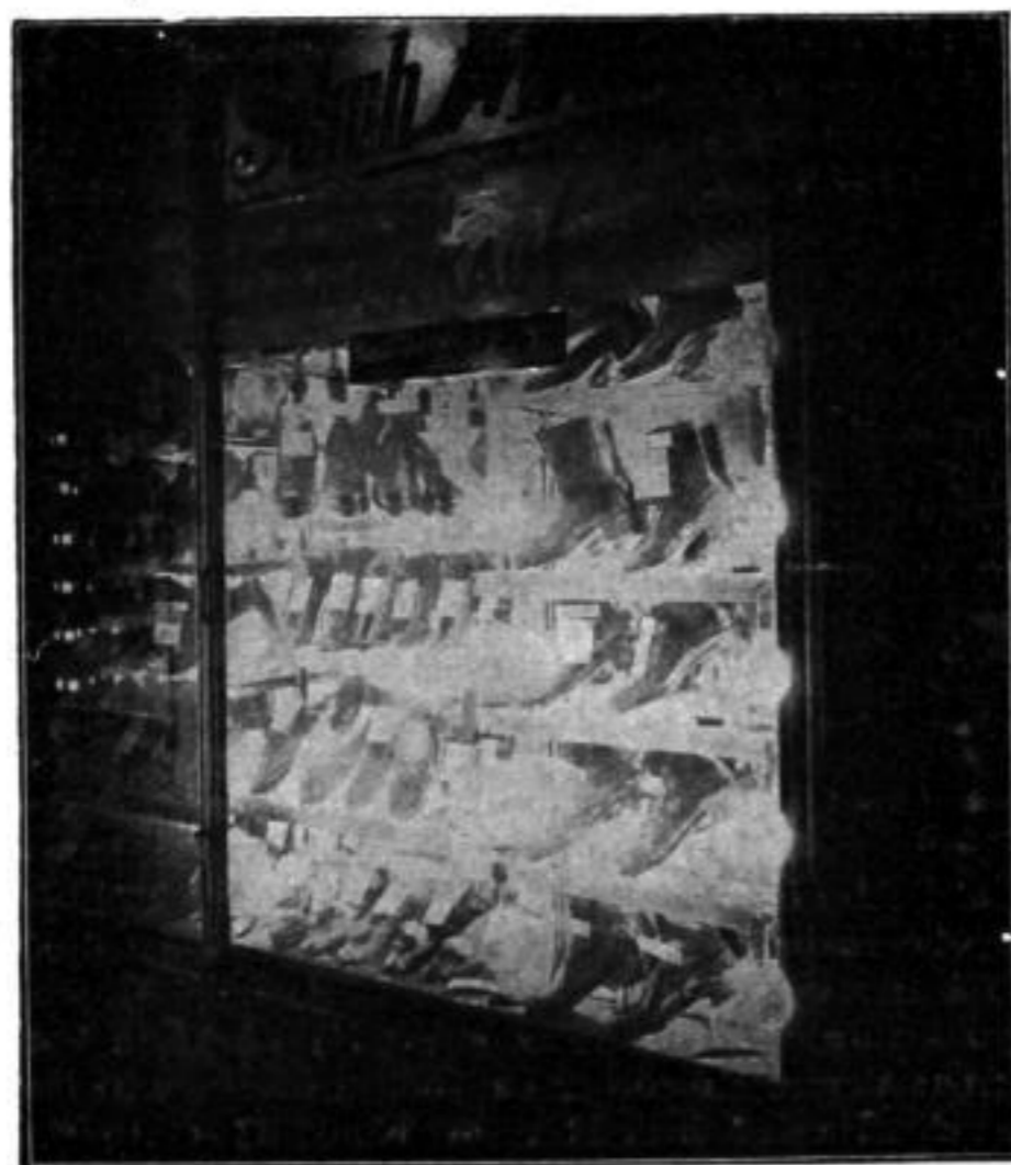
Abb. 1. Die typische schlechte Schaukastenbeleuchtung mit blendenden Klarglaslampen
